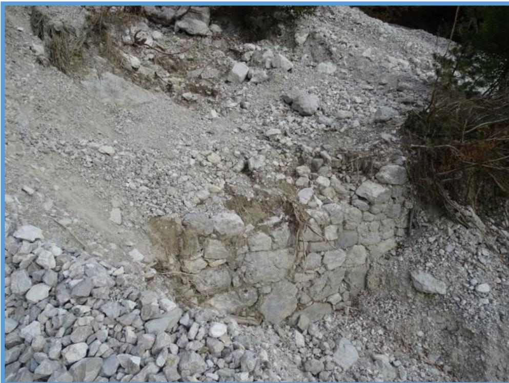
Figura 27 : Particolare della foto precedente. L'erosione prodotta dal flusso detritico ha portato alla luce una preesistente opera muraria.
