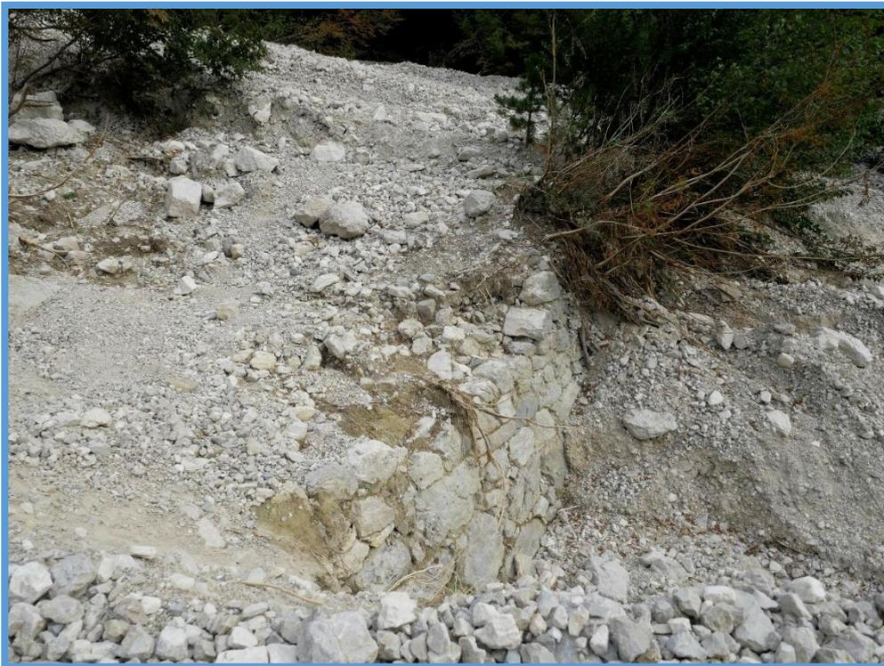
Figura 42: Opere di sistemazione dell'alveo riportate alla luce dai recenti eventi alluvionali lungo il canalone A.
