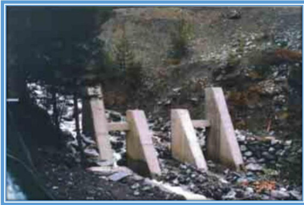
Figura 52: Esempio di briglia aperta idonea alla intercettazione di massi di grosse dimensioni.
